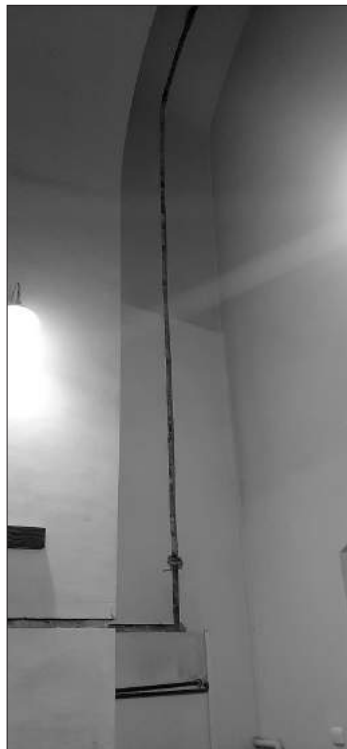
Montaż dodatkowych czujek sygnalizacji przeciwpożarowej w zakrystii
