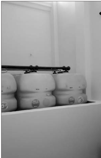
Odmalowane pomieszczenia kotłowni
