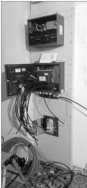
Instalacja centrali sygnalizacji przeciwpożarowej w zakrystii
