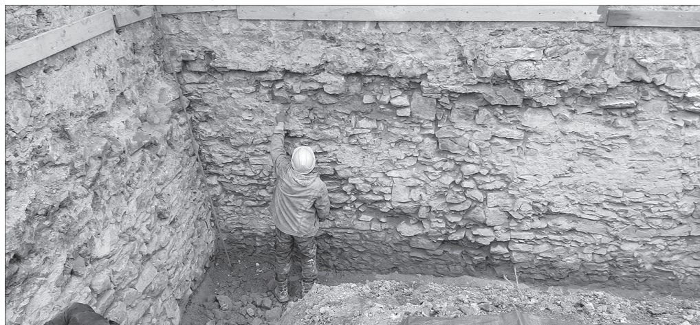
Czyszczenie fundamentów kościoła fot. Marcin Gabryś
