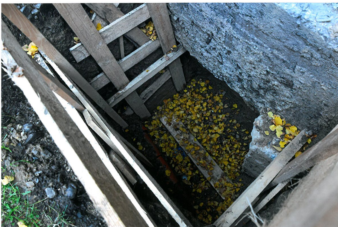
Elewacja wschodnia – odkrywka fundamentu nr 2. Stan zachowania kościoła przed konserwacją. Widoczne betonowe wzmocnienie ściany fundamentowej i fragment dodatkowej opaski wzmacniającej na poziomie łąwy.
